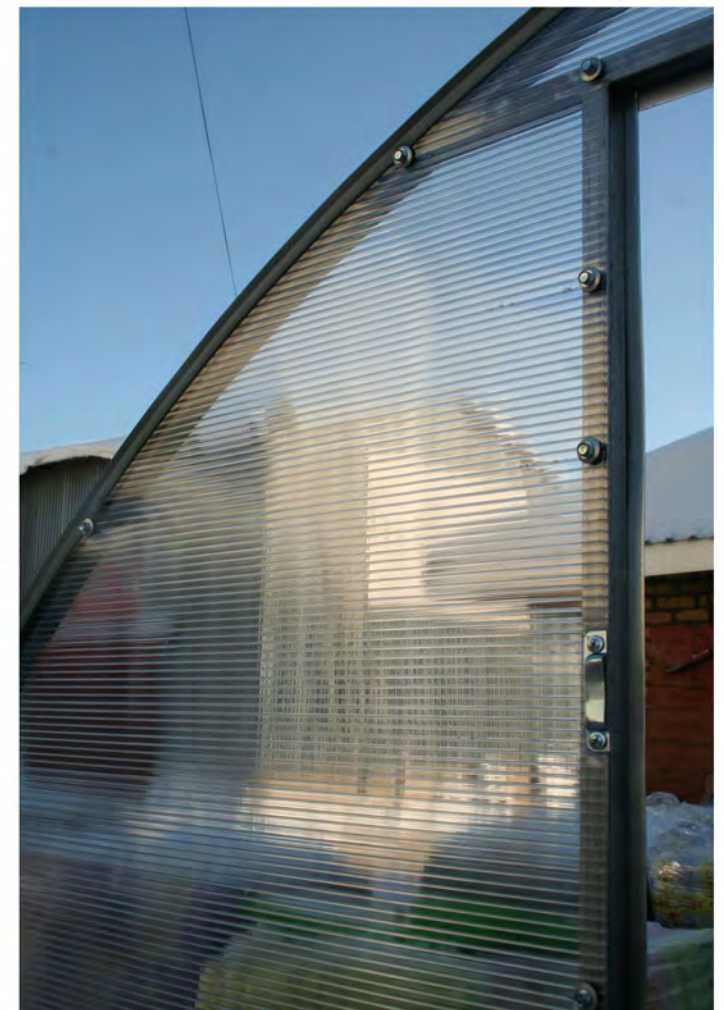
Крючок для фиксации двери в открытом положении
